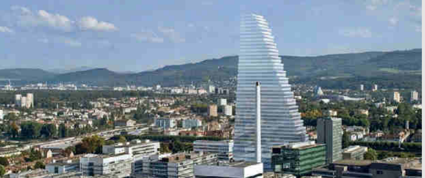
Holcim entwickelte einen speziellen Beton und eine individuelle Logistik-Lösung für den Roche-Tower
