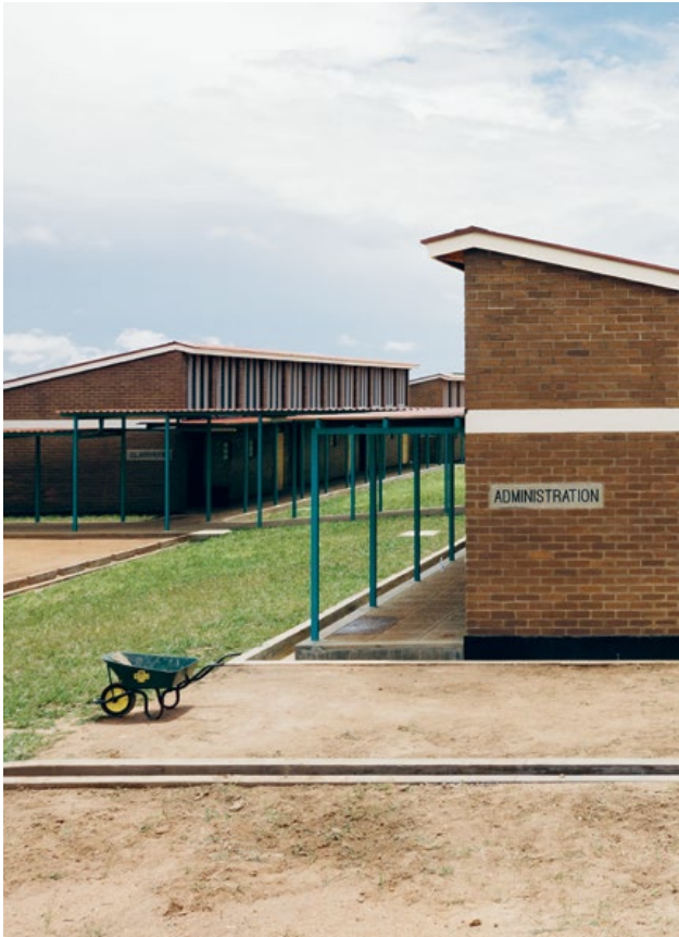
Das Teacher Training College in Lilongwe wurde 2016 mit DURABRIC gebaut.
