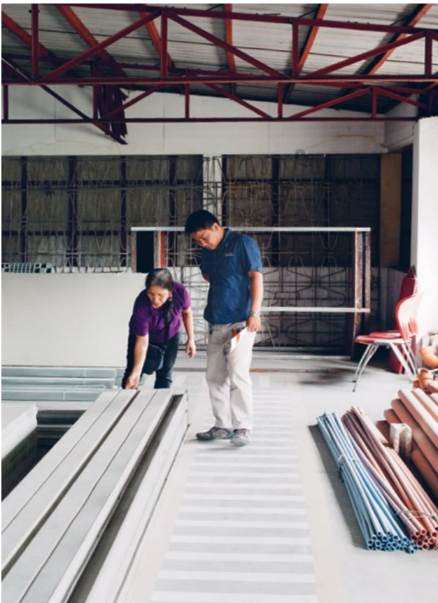
Nida Santa Romana hat ihr Haus mit Zement und anderen Materialien aus ihrem lokalen HUB-Markt gebaut.
