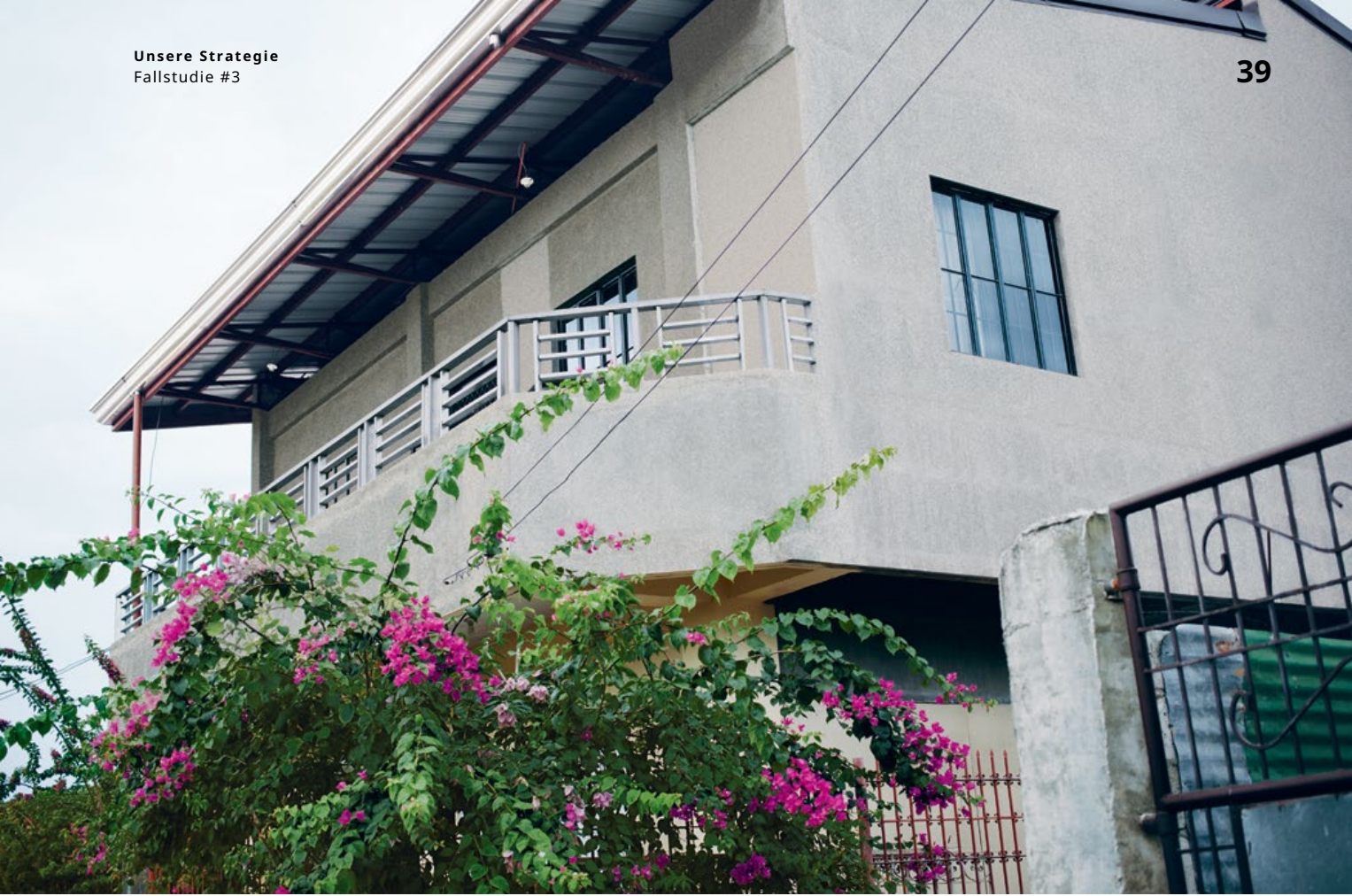
Das Haus von Nida Santa Romana befindet sich kurz vor der Fertigstellung.
