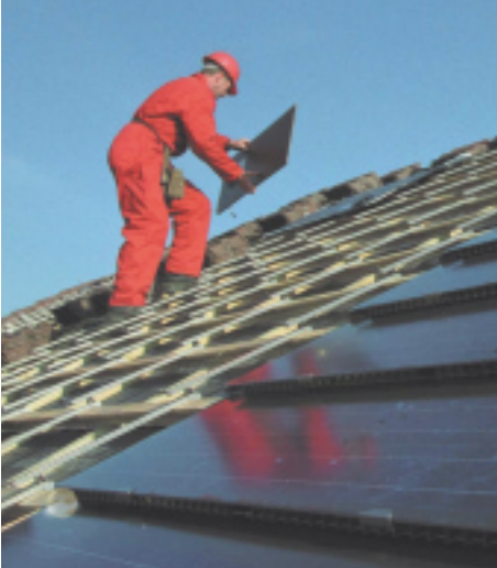
TOITURE | Installation d'un système photovoltaïque
