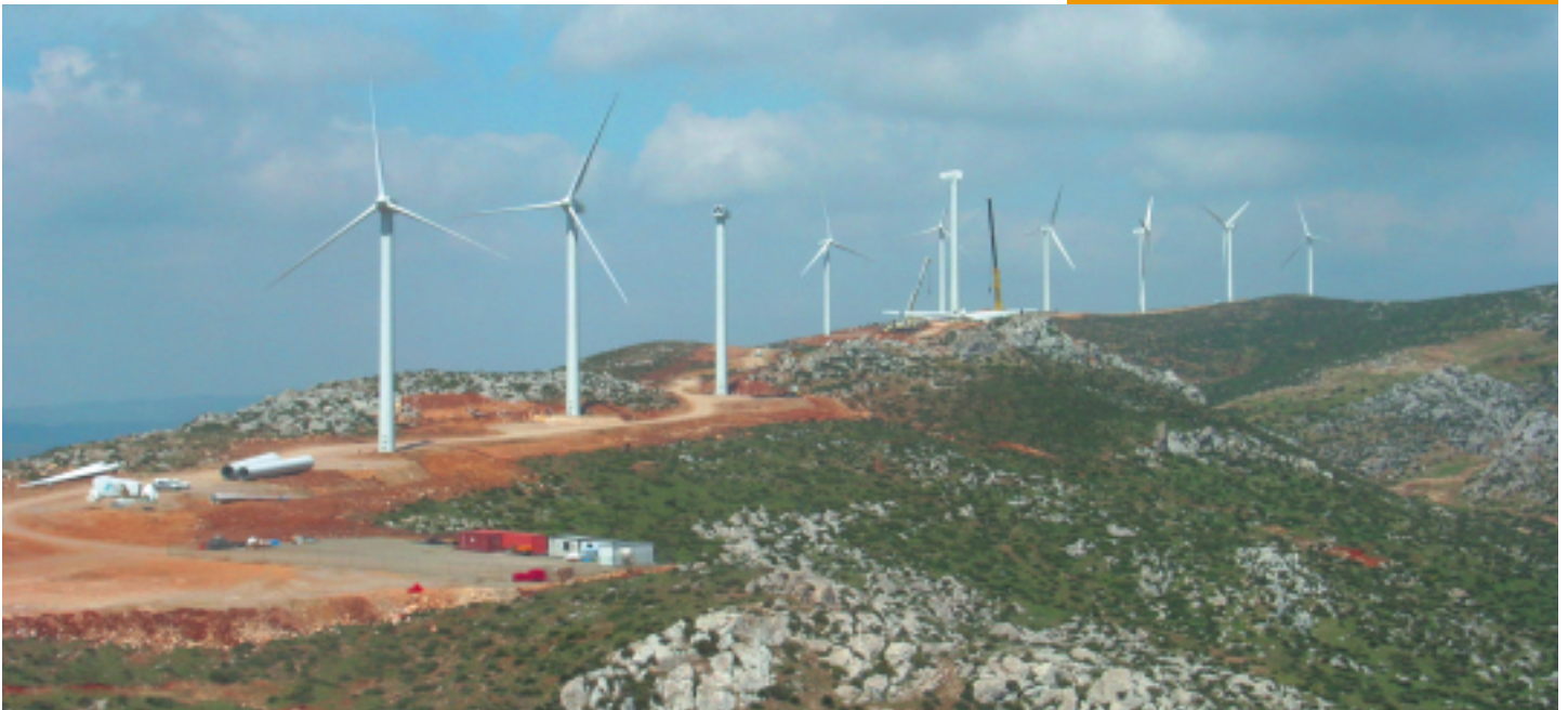
MAROC | Parc d'éoliennes en construction à la cimenterie de Tétouan II
