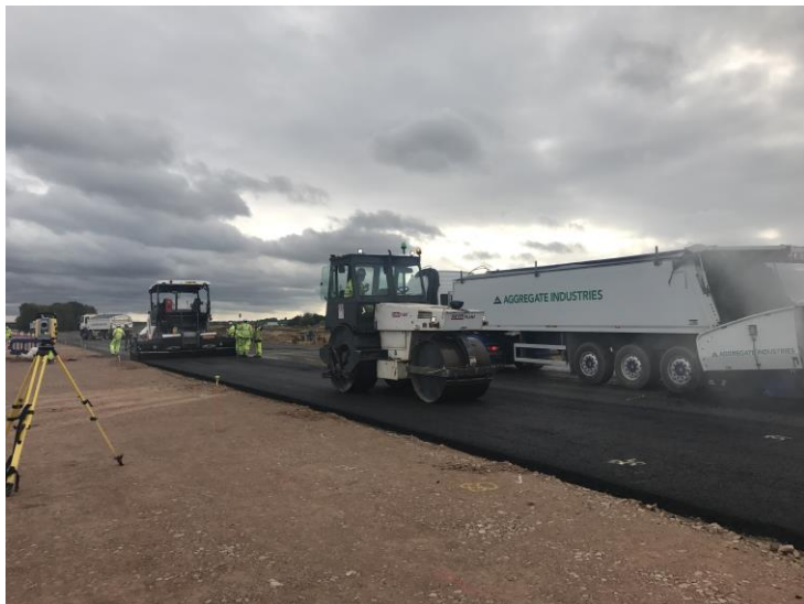
Foto: Bauarbeiten an der Autobahn A14
